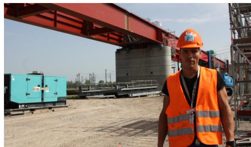
Chef d'équipe employé par l'entreprise ZM, Giacomo Scarlata veille au bien-être de ses "gars". Il remarque que depuis les fortes chaleurs "le ravitaillement en eau a doublé".
